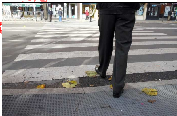
Bordillo rebajado en paso de peatones.
