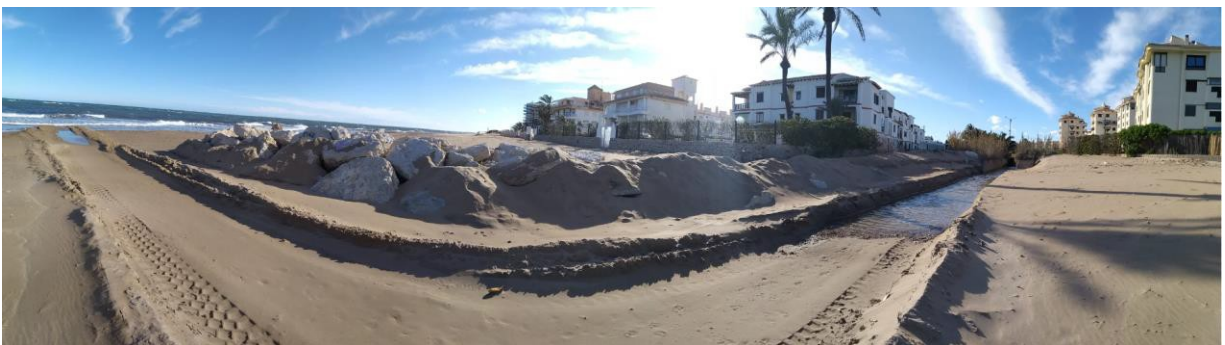
Fotografia 17 Platja "Les Bovetes". Desembocadura de desguàs de drenatge natural.
