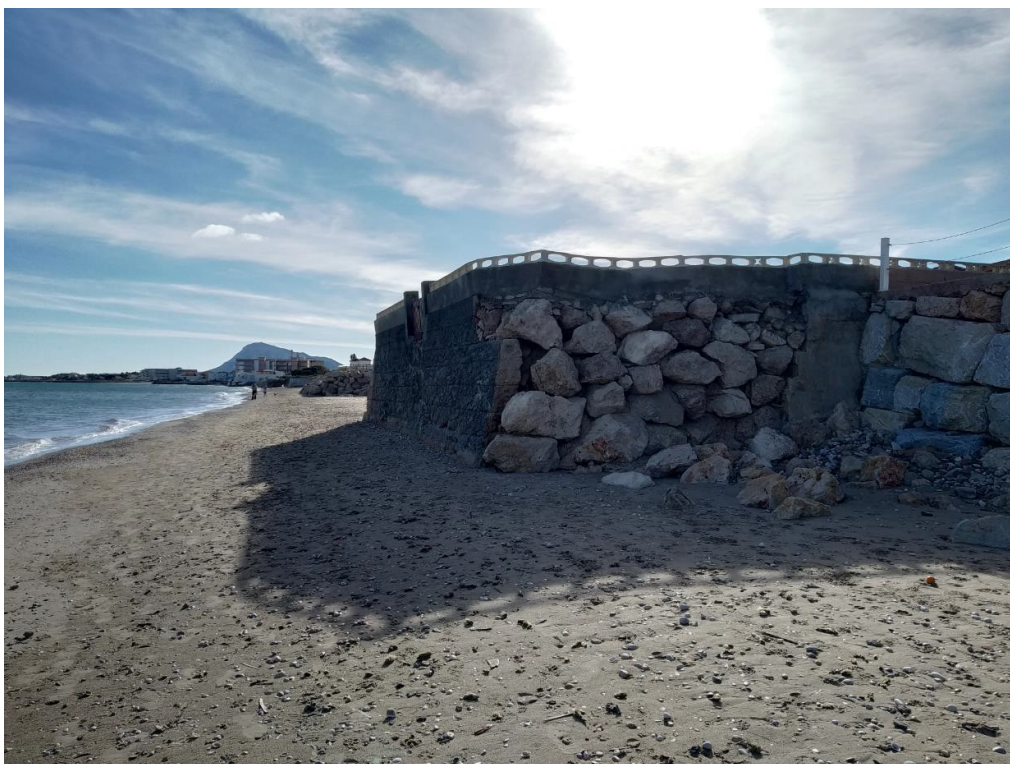
Fotografia 4 Platja "Les Deveses". Perill de danys o lesions per restes d'enderrocs de murs i defenses de construccions.
